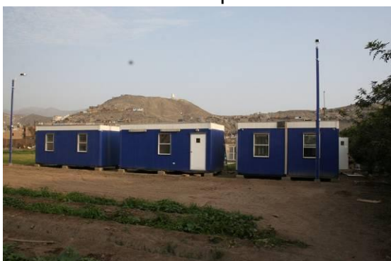
Inst. de módulos de oficina y dormitorio
