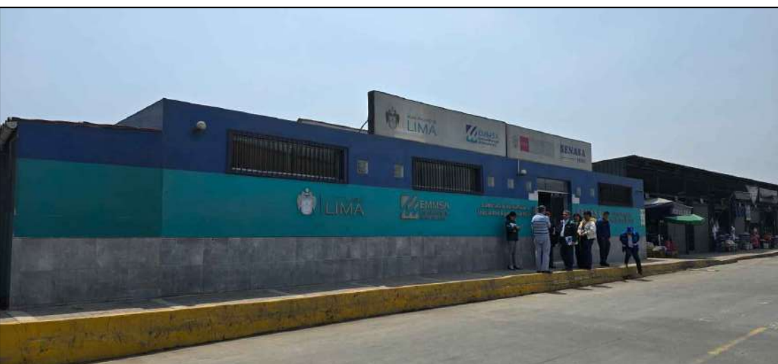
✓ Fachad Principal - Estado actual
